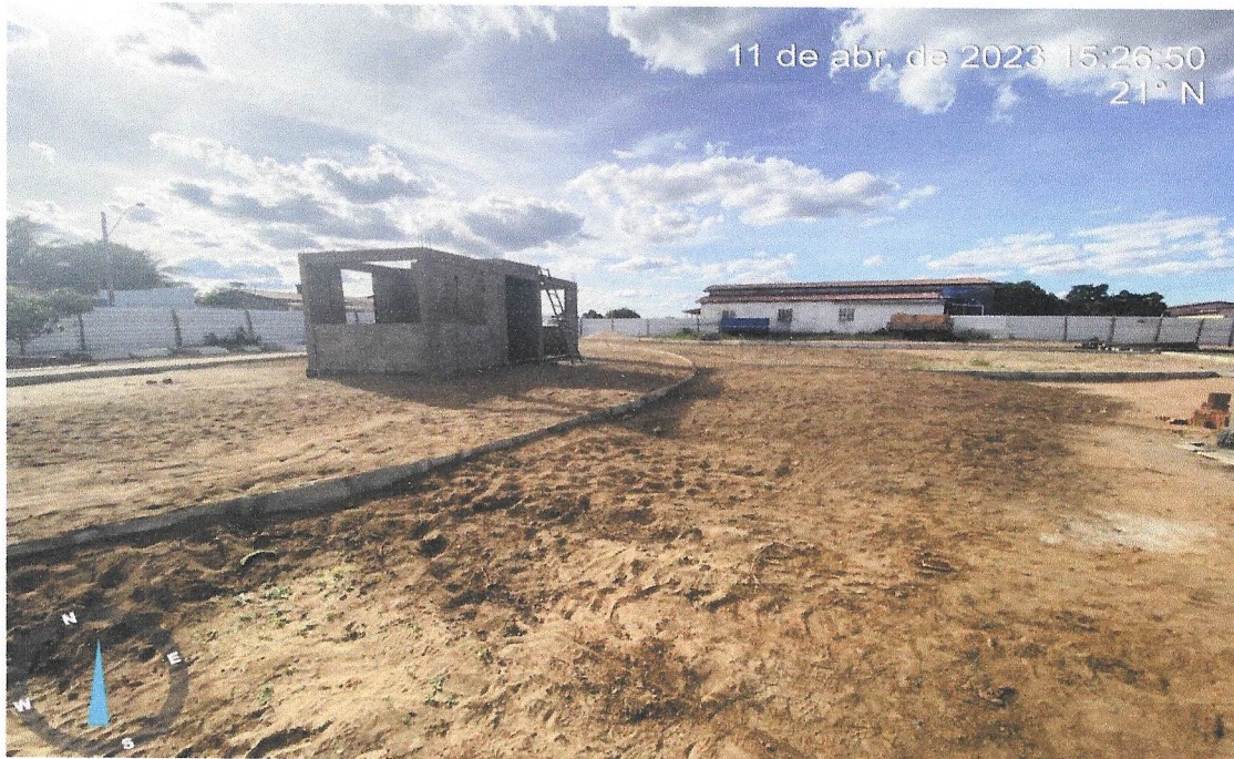
Foto 17 – ATERRO E COMPACTAÇÃO.
