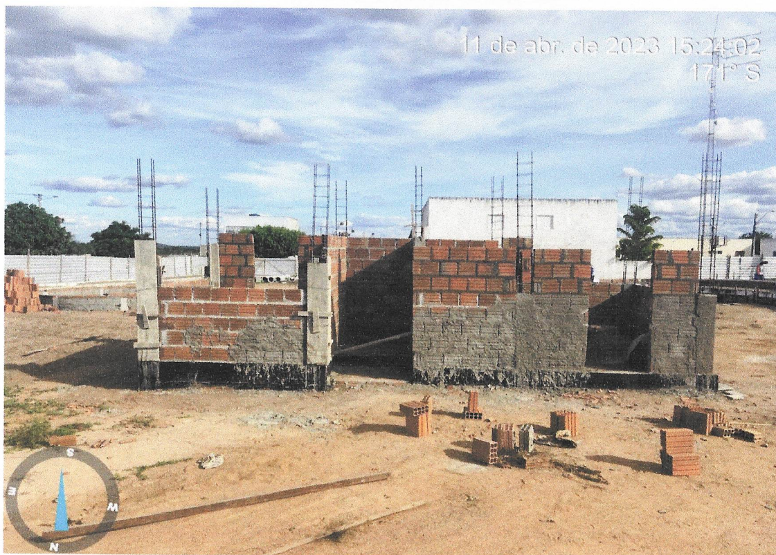
Foto 08 – EXECUÇÃO DE ESTRUTURAS DE CONCRETO ARMADO, PARA EDIFICAÇÃO HABITACIONAL UNIFAMILIAR TÉRREA.
