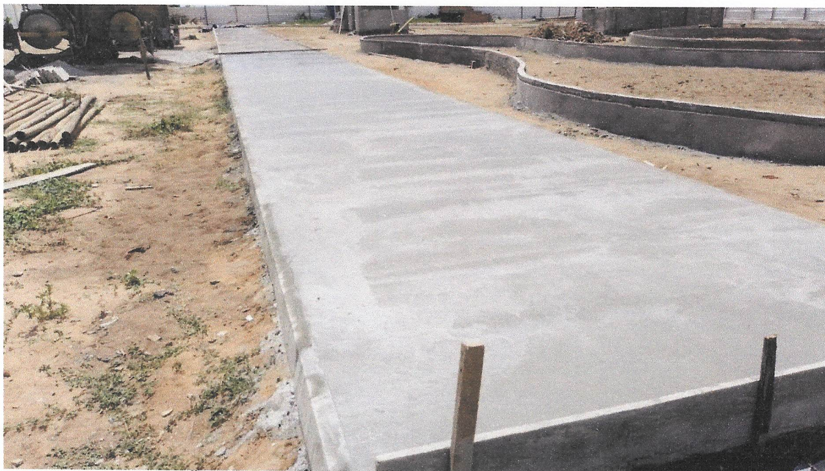
FOTO 29 - EXECUÇÃO DE PASSEIO (CALÇADA) OU PISO DE CONCRETO COM CONCRETO MOLDADO IN LOCO, FEITO EM OBRA, ACABAMENTO CONVENCIONAL, ESPESSURA 6 CM
