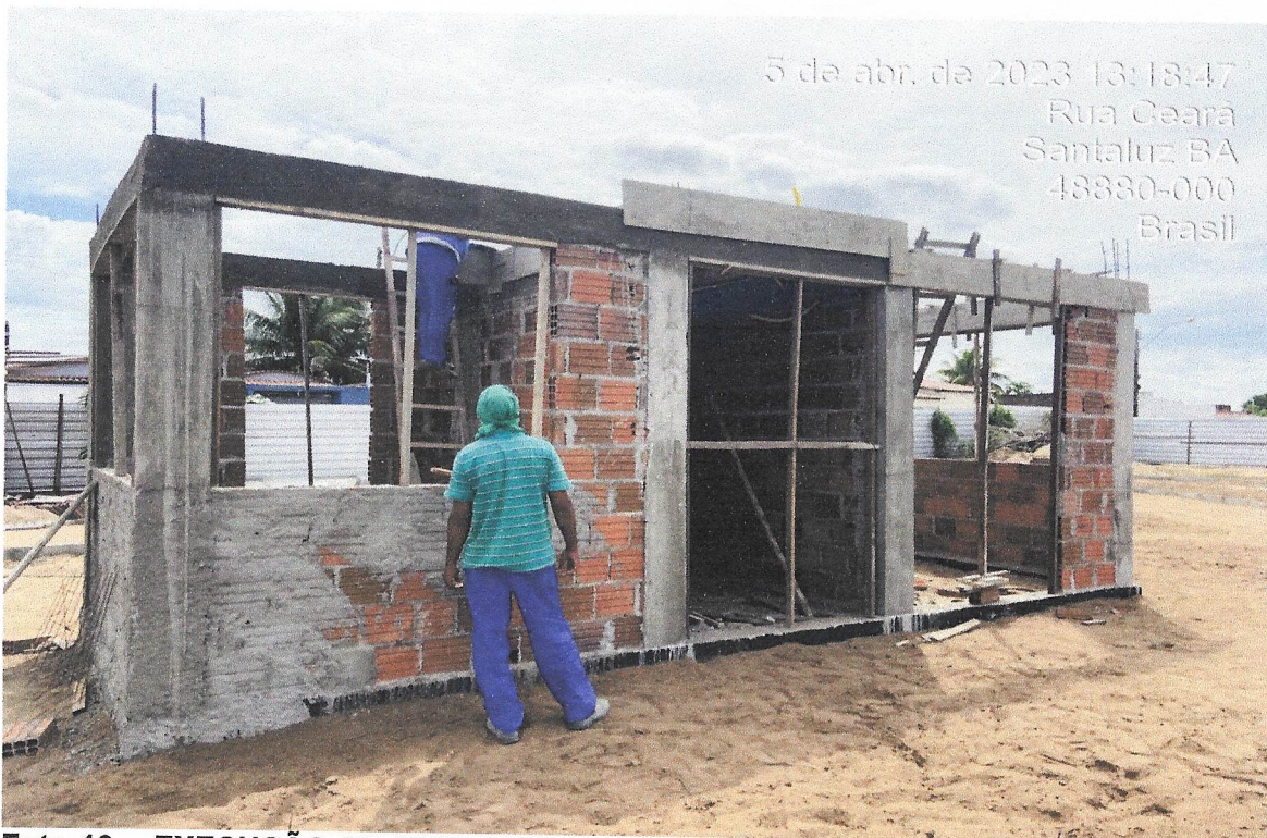
Foto 13 – EXECUÇÃO DE ESTRUTURAS DE CONCRETO ARMADO, PARA EDIFICAÇÃO HABITACIONAL UNIFAMILIAR TÉRREA.
