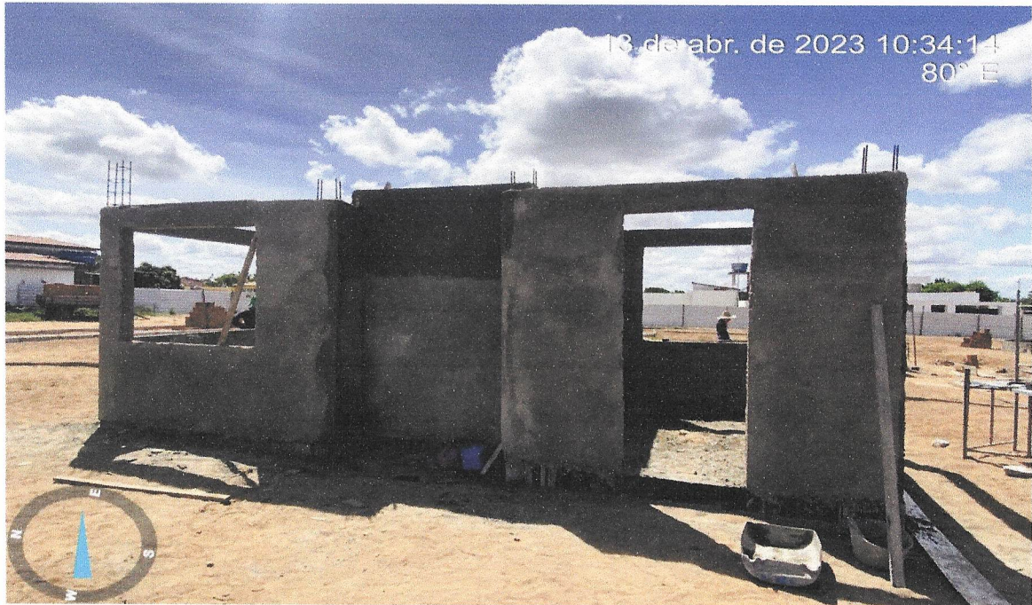
Foto 15 – EXECUÇÃO DE MASSA ÚNICA.
