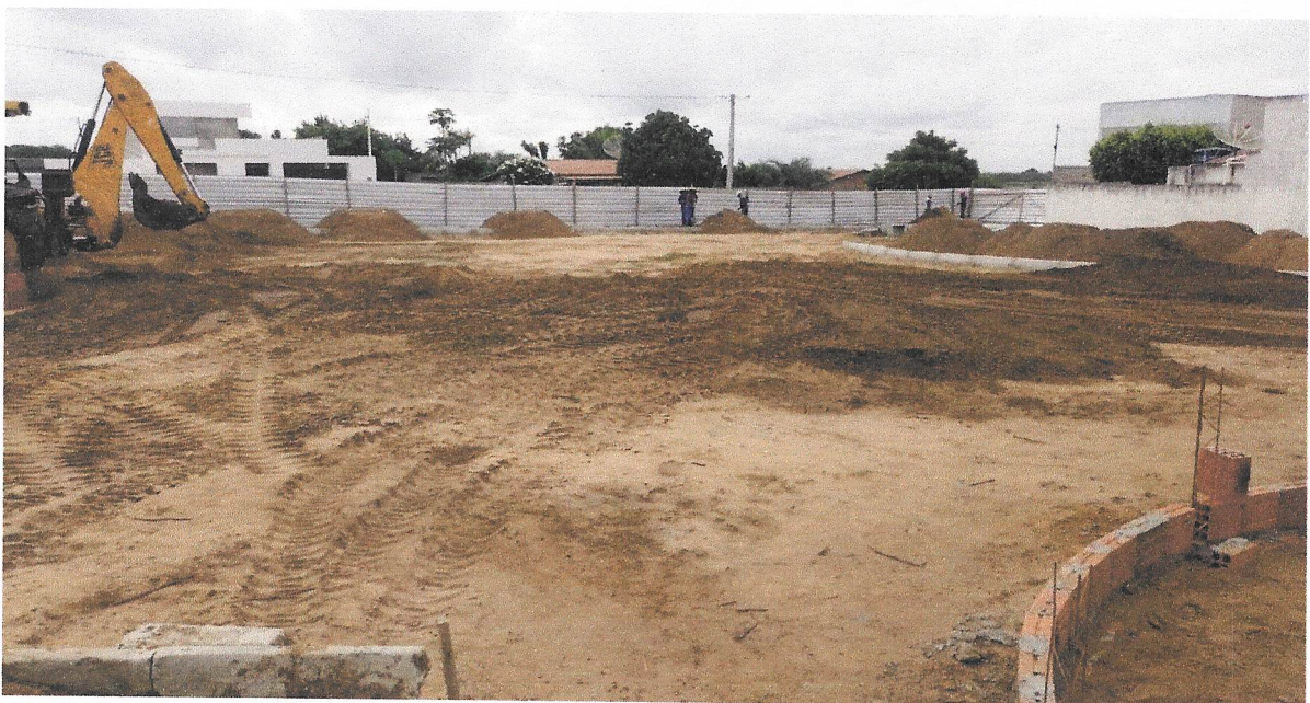
Foto 02 – ATERRO MANUAL DE VALAS COM AREIA PARA ATERRO E COMPACTAÇÃO MECANIZADA.
