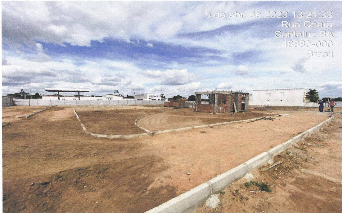
Foto 05 – ATERRO MANUAL DE VALAS COM AREIA PARA ATERRO E COMPACTAÇÃO MECANIZADA.
