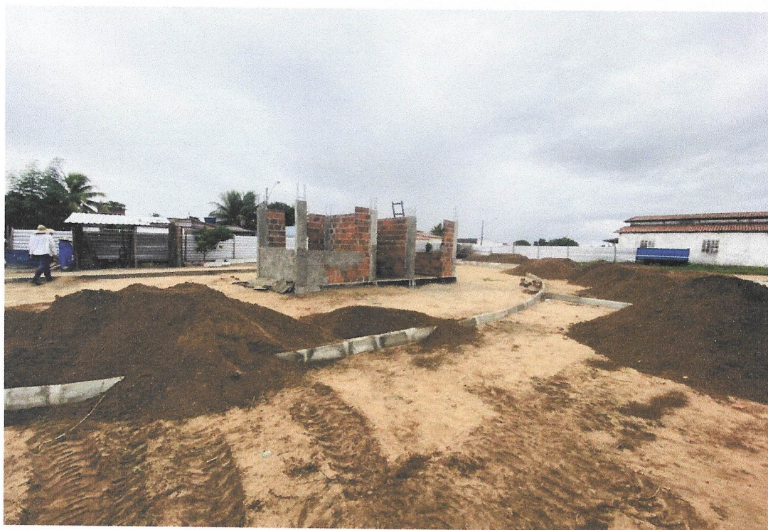
Foto 03 – ATERRO MANUAL DE VALAS COM AREIA PARA ATERRO E COMPACTAÇÃO MECANIZADA.
