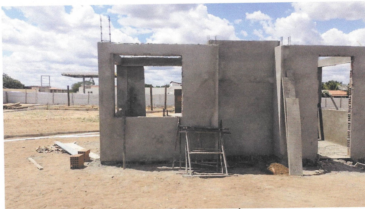
FOTO 25- EXECUÇÃO DE MASSA ÚNICA
