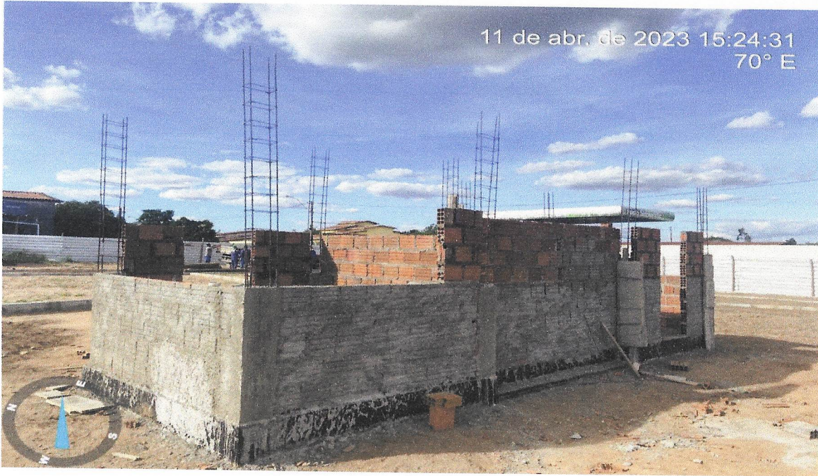
Foto 09 – EXECUÇÃO DE ESTRUTURAS DE CONCRETO ARMADO, PARA EDIFICAÇÃO HABITACIONAL UNIFAMILIAR TÉRREA.
