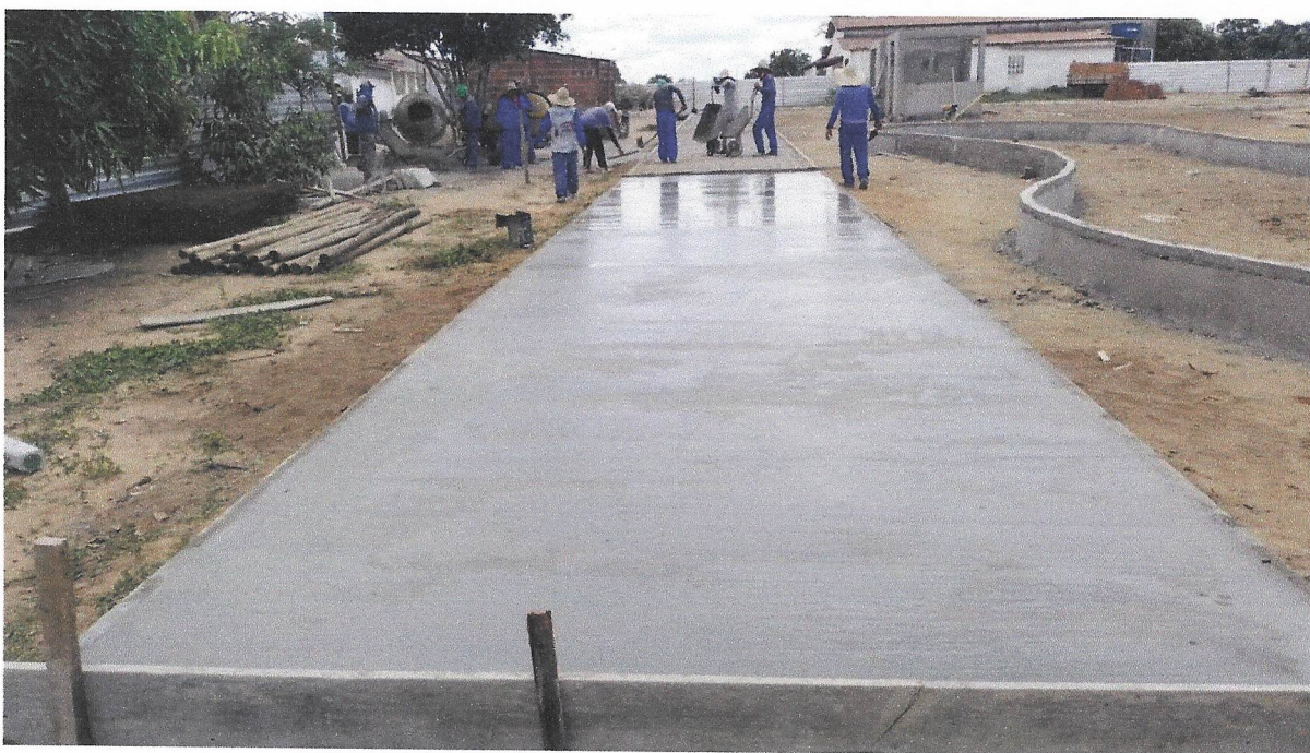
FOTO 30 - EXECUÇÃO DE PASSEIO (CALÇADA) OU PISO DE CONCRETO COM CONCRETO MOLDADO IN LOCO, FEITO EM OBRA, ACABAMENTO CONVENCIONAL, ESPESSURA 6 CM
