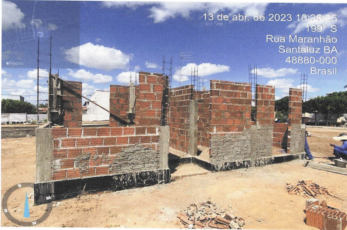
Foto 11 – LEVEANTE DE ALVENARIA.
