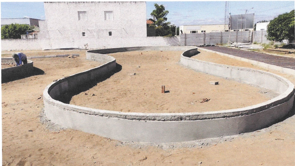
FOTO 24 - CANTEIROS E BANCOS: EXECUÇÃO DE MASSA ÚNICA.
