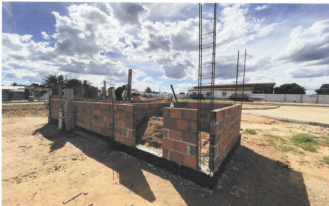
Foto 07 – EXECUÇÃO DE ESTRUTURAS DE CONCRETO ARMADO, PARA EDIFICAÇÃO HABITACIONAL UNIFAMILIAR TÉRREA.
