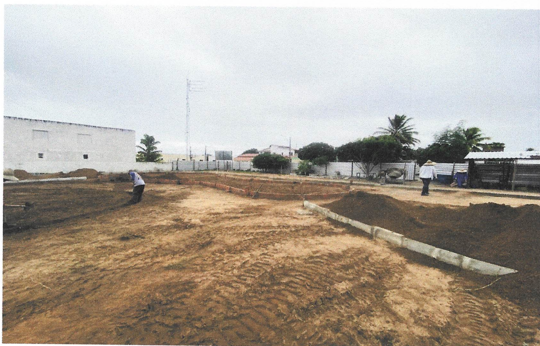
Foto 04 – ATERRO MANUAL DE VALAS COM AREIA PARA ATERRO E COMPACTAÇÃO MECANIZADA.
