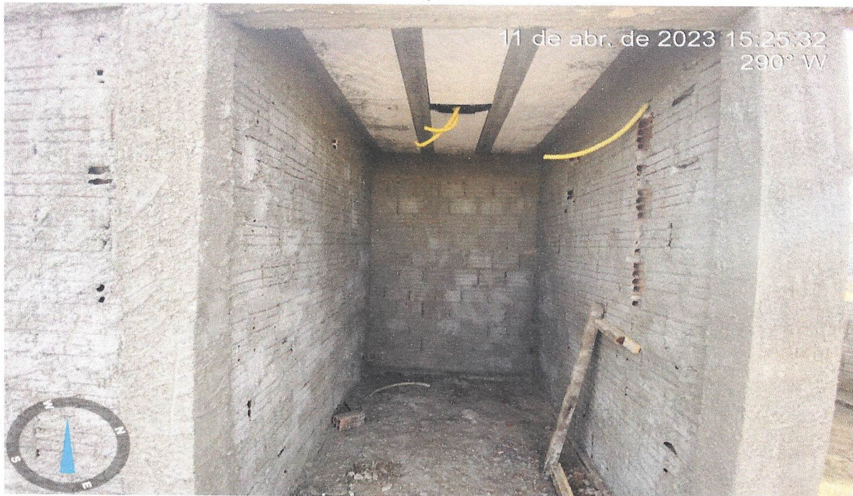
Foto 16 – Laje pré-fabricada treliçada para piso ou cobertura, intereixo 38cm, h=12cm.
