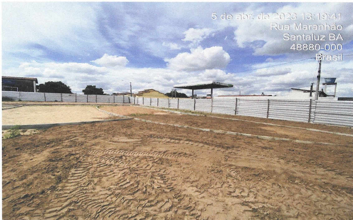
Foto 06 – ATERRO MANUAL DE VALAS COM AREIA PARA ATERRO E COMPACTAÇÃO MECANIZADA.
