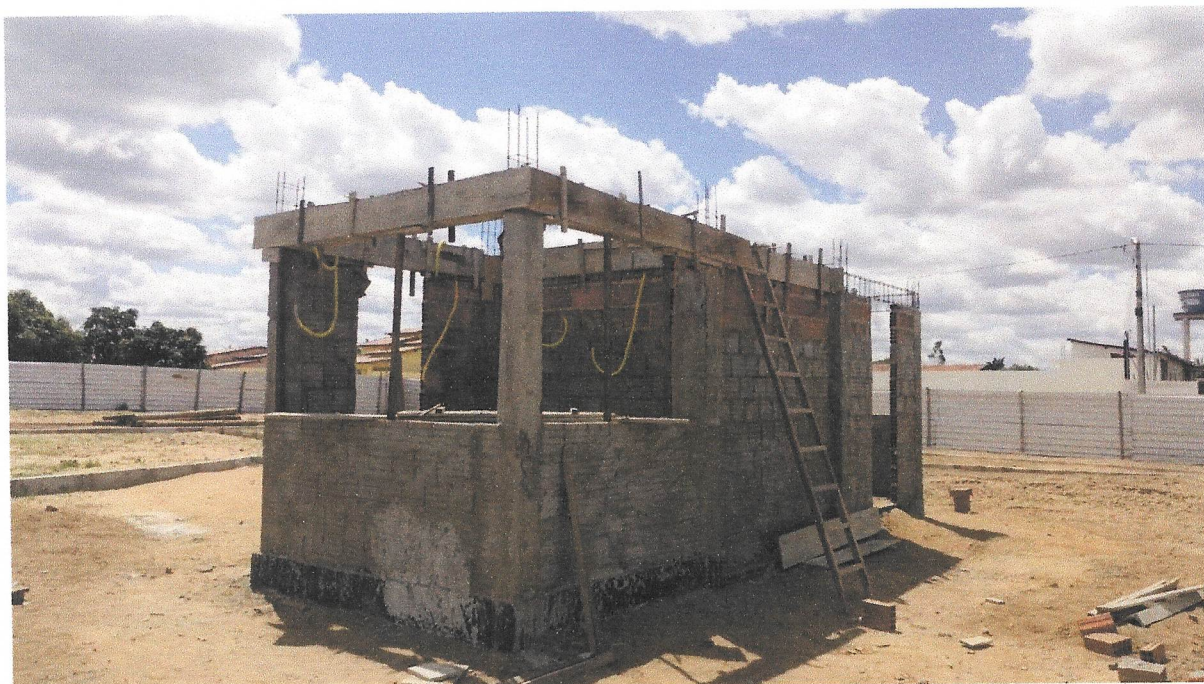
FOTO 26- EXECUÇÃO DE VIGAS AERIAS E CHAPISCO
