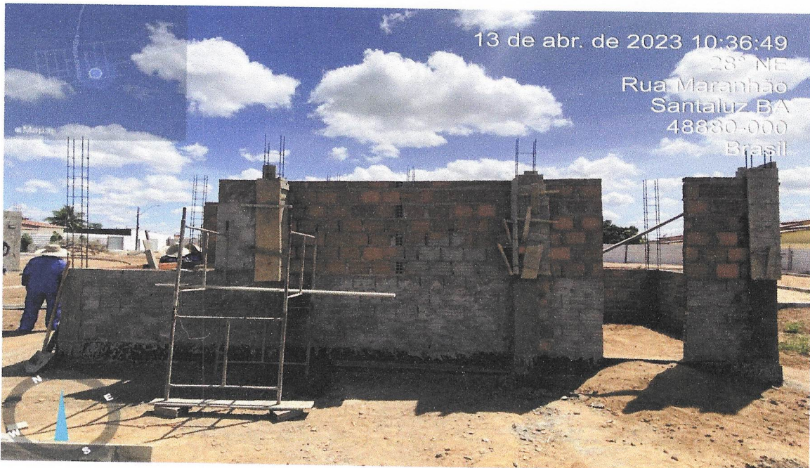
Foto 10 – LEVANTE DE ALVENARIA
