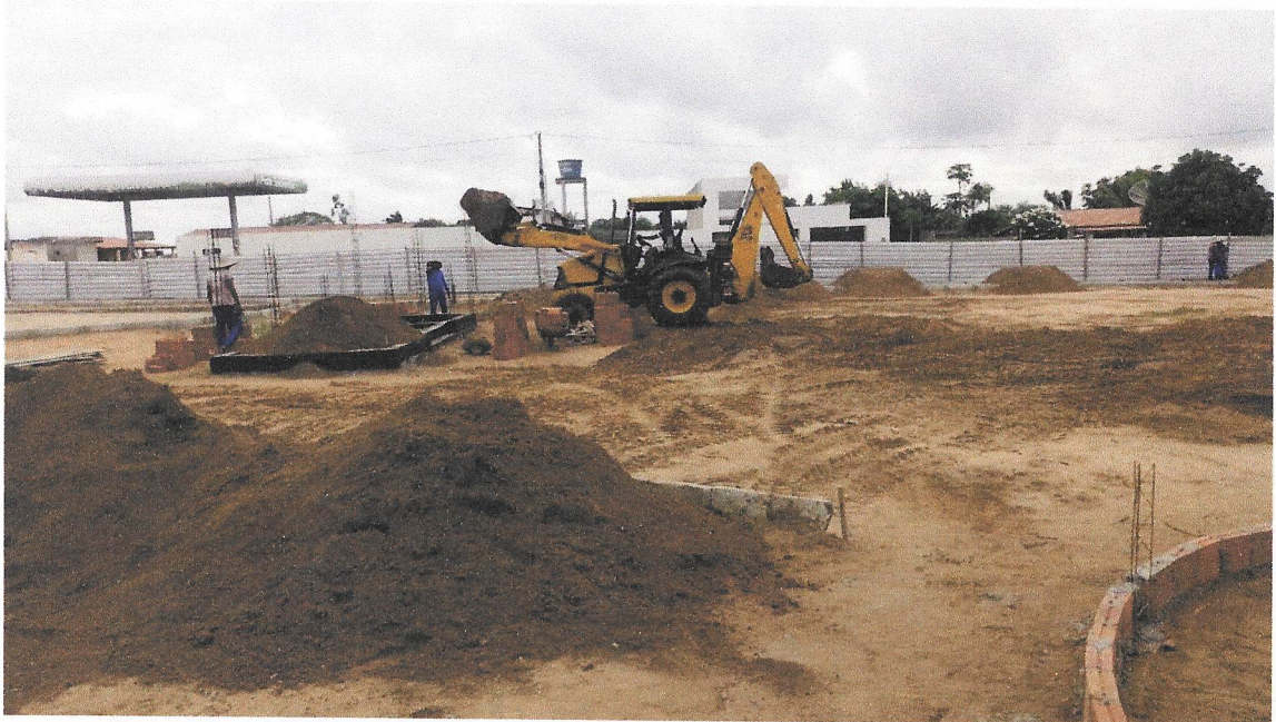
Foto 01 – ATERRO MANUAL DE VALAS COM AREIA PARA ATERRO E COMPACTAÇÃO MECANIZADA.
