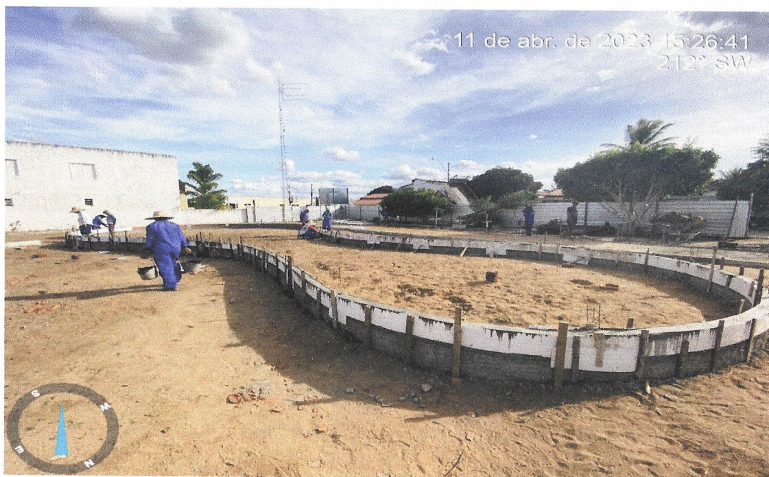
Foto 18 - EXECUÇÃO DE ESTRUTURAS DE CONCRETO ARMADO.
