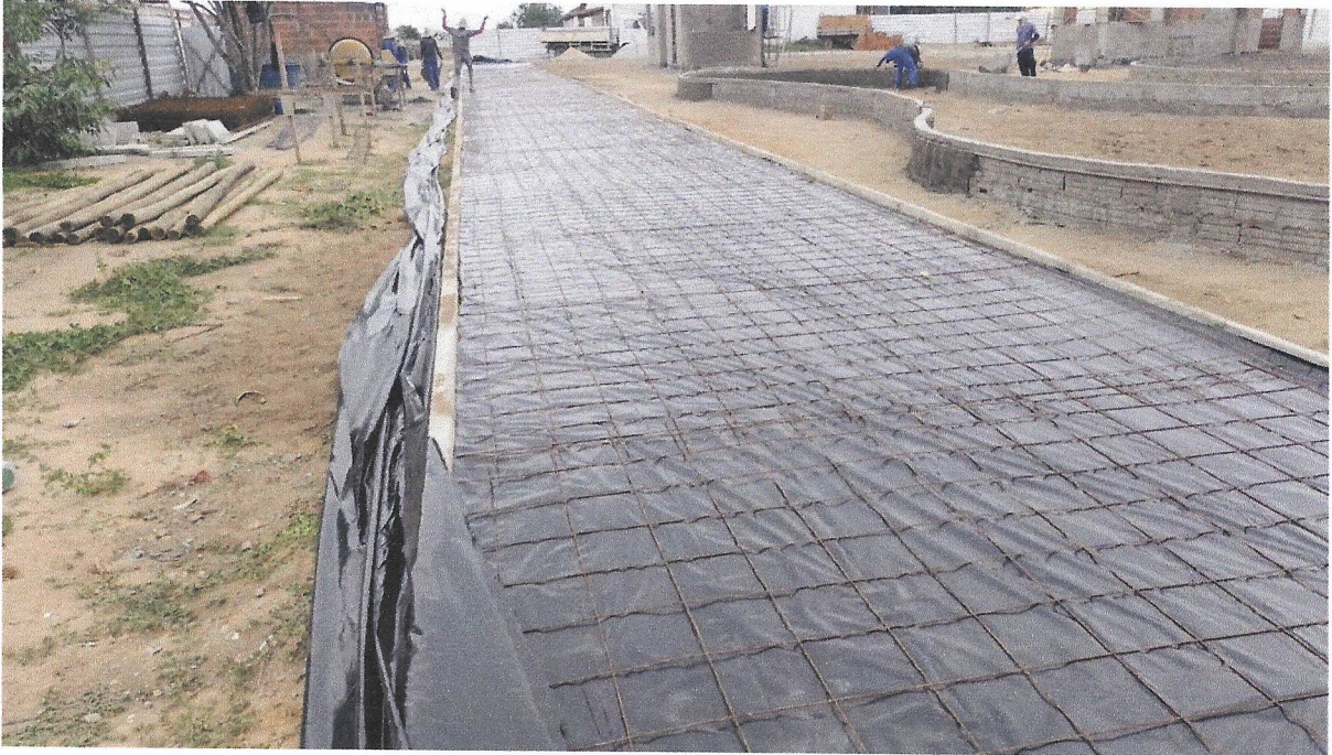
FOTO 27 - EXECUÇÃO DE PASSEIO (CALÇADA) OU PISO DE CONCRETO COM CONCRETO MOLDADO IN LOCO, FEITO EM OBRA, ACABAMENTO CONVENCIONAL, ESPESSURA 6 CM
